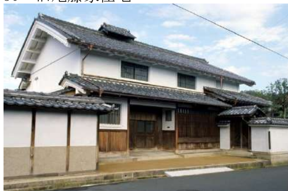
31 西山機業場の建物群
