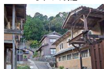
西山工場(丹後最古のちりめん工場)
