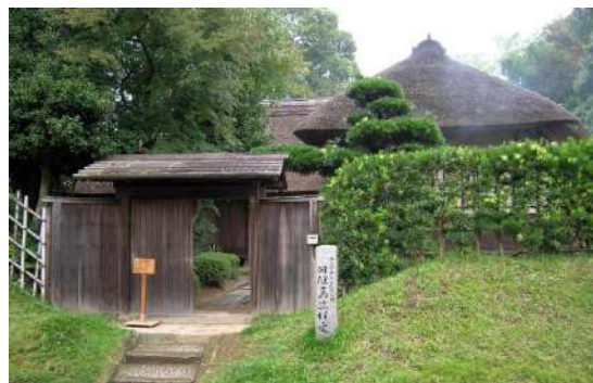
1-2 石高150石の武家屋敷 (市有形 旧但馬家住宅)
