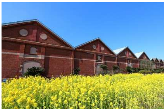
24 ニッカウキスキー(株)門司工場 倉庫 (旧大里製粉所倉庫)
