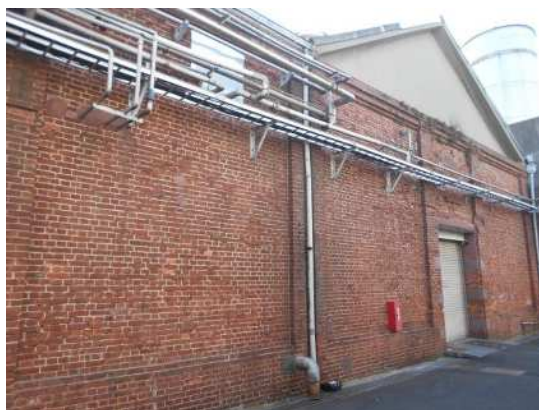
23 ニッカウキスキー(株)門司工場 製造場 (旧大里酒精製造所 製造場)
