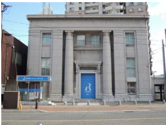
31 中国労働金庫下関支店 (旧不動貯金銀行下関支店)
