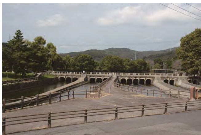
18 高梁川東西用水取配水施設
