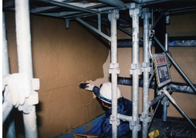
珓直し(主屋吹抜)。壁土は何層にも塗り重ねる
