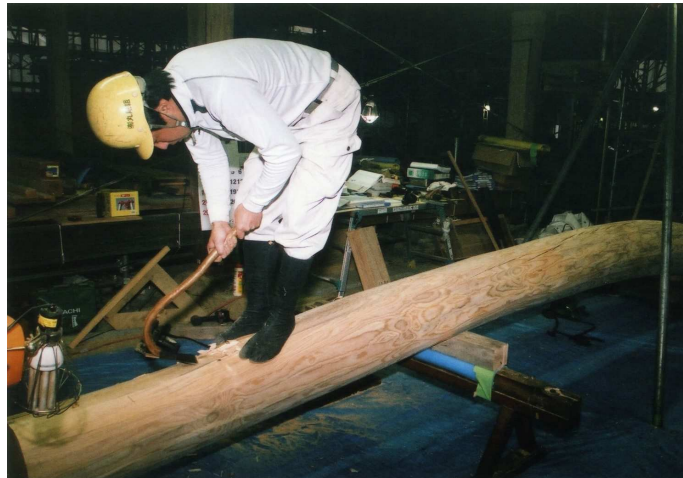
伝統的な工具、鉦(ちょうな)を使った加工
