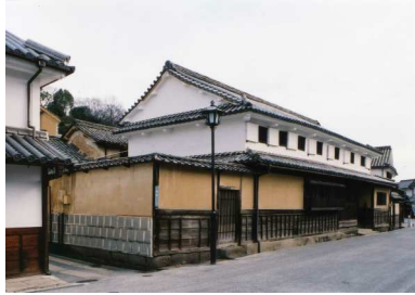
主屋修理前正側面
