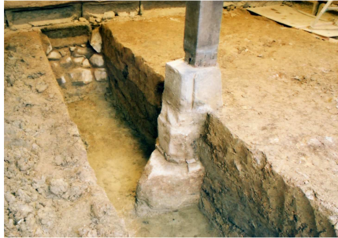
三階蔵中央柱の地業
