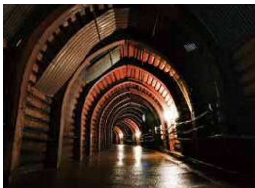
生野鉱山坑道内(朝来市)
