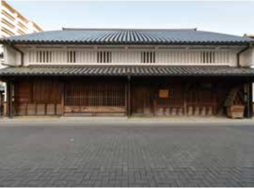
現存する日本最古の酒蔵「旧岡田家住宅・酒蔵」（伊丹市）
